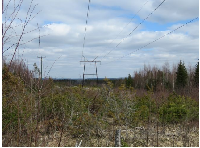
Kuva 8. Voimalinja suunnittelualueen koillisosassa, kuvattu koilliseen.
