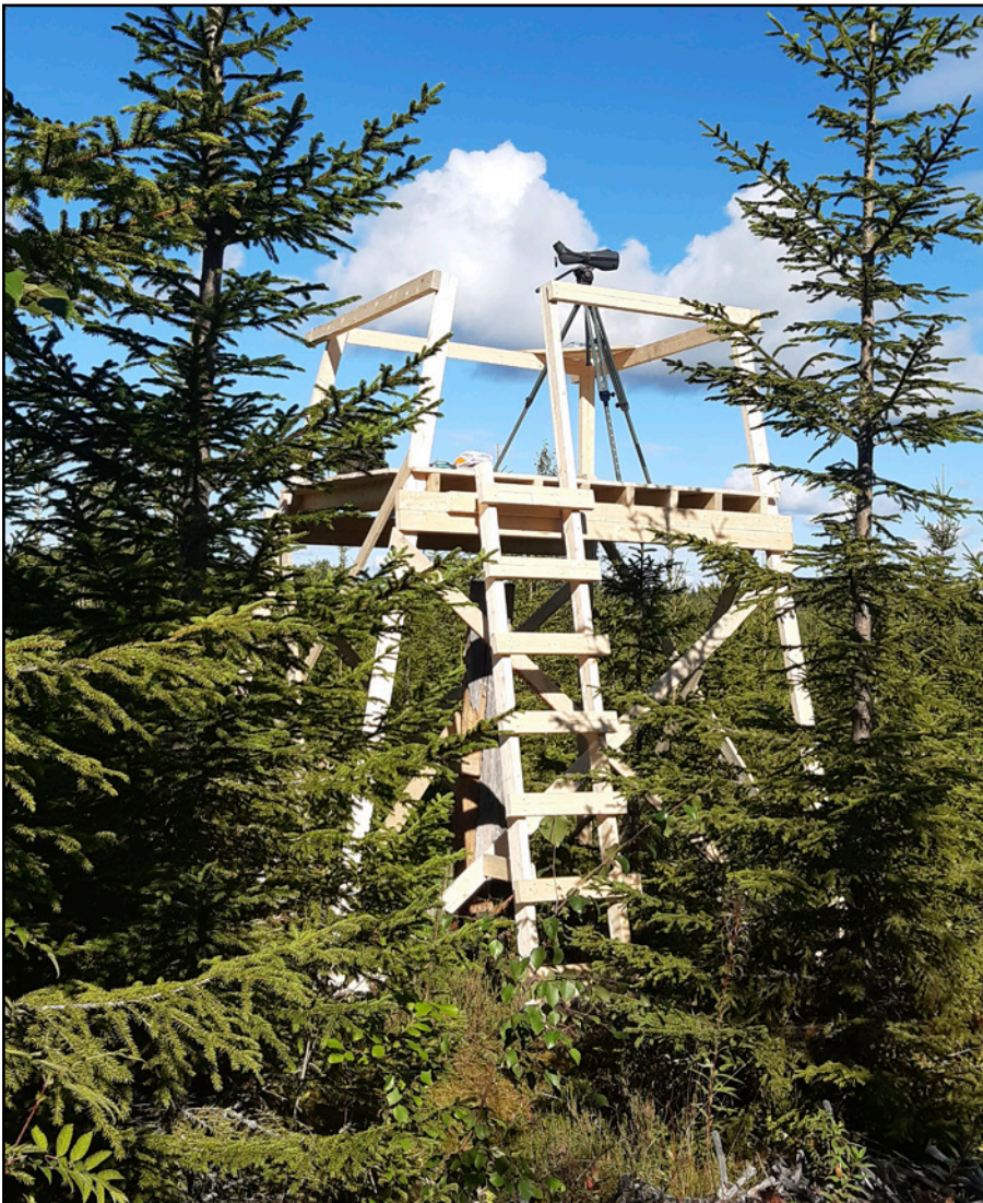
Kuva 2. Pitkälänvuorelle rakennettu havainnointitorni.
