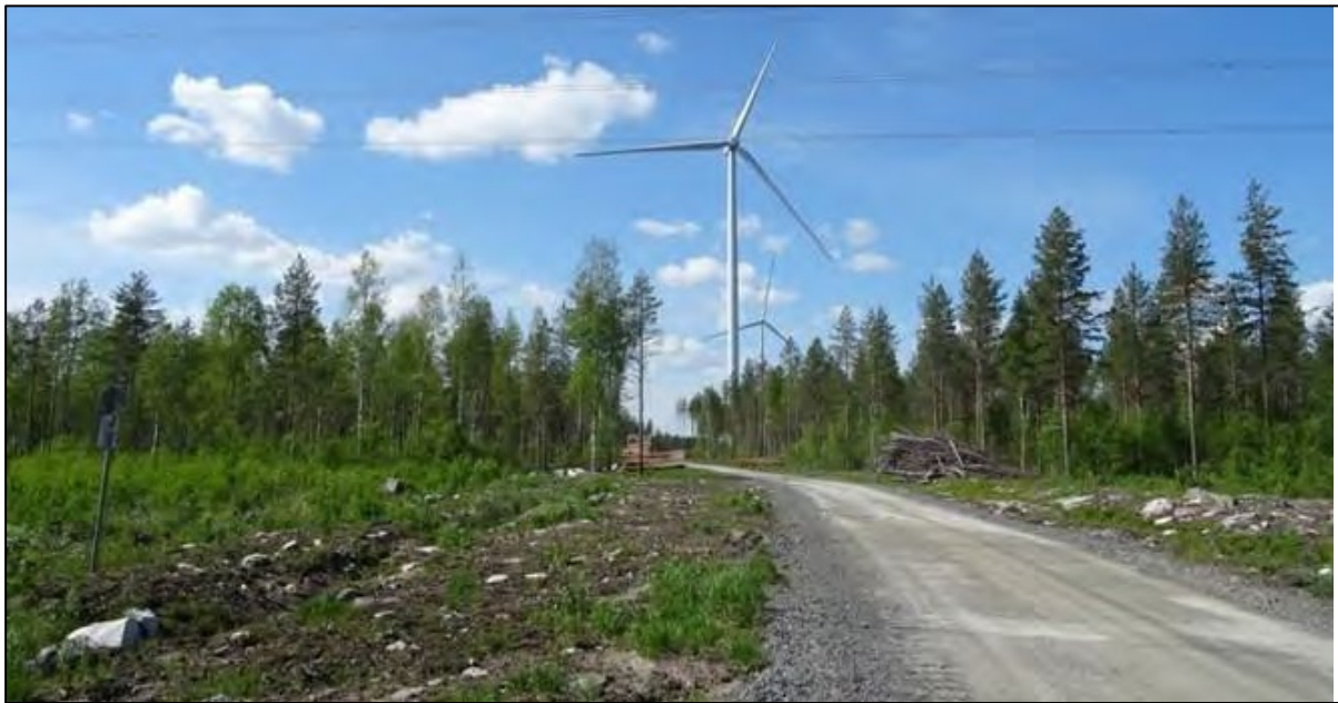
Kuva 46. Esimerkki tuulivoimapuiston rakennus- ja huoltotiestä. Teitä käytetään muun muassa betonin ja soran sekä voimaloiden komponenttien kuljetuksiin. Tuulivoimapuiston käyttövaiheessa teitä käytetään mm. vuosittaisissa huolloissa. Maakaapelioja on sijoitettu kuvassa tien vasemmalle puolelle.
