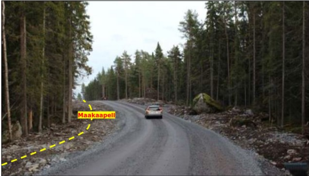
Kuva 7. Esimerkki tuulivoimapuiston rakennus- ja huoltotiestä.
