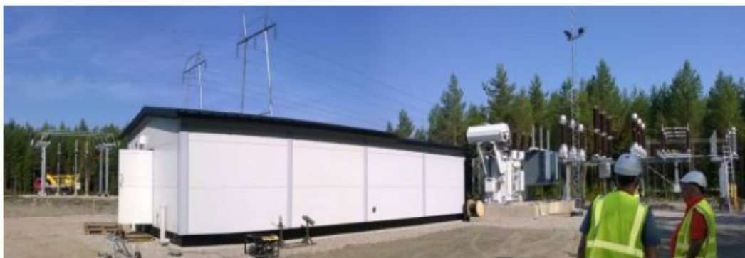
Kuva 9. Esimerkki rakenteilla olevasta tuulivoimapuiston sähköasemasta. FCG Suunnittelu ja Tekniikka Oy, 2016.
