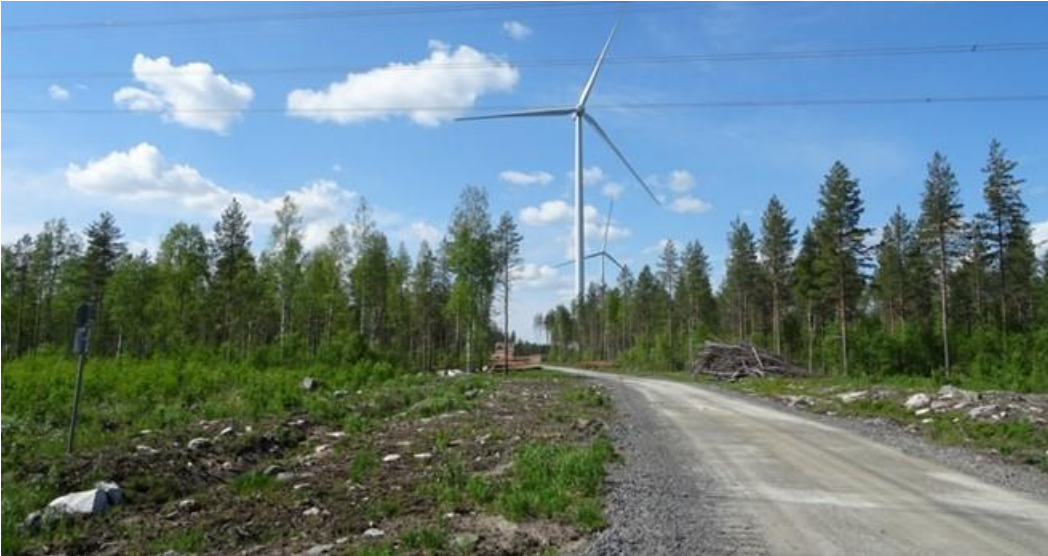
Kuva 8. Esimerkki tuulivoimapuiston rakennus- ja huoltotiestä. Teitä käytetään muun muassa betonin ja soran sekä voimaloiden komponenttien kuljetuksiin. Tuulivoimapuiston käyttövaiheessa teitä käytetään mm. vuosittaisissa huolloissa. Maakaapelin oja on sijoitettu tien vasemmalle puolelle.
