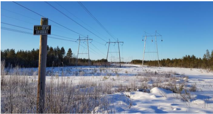
Sähköasema ja voimalinjat Humpinmäentieltä avautuvissa näkymissä.
