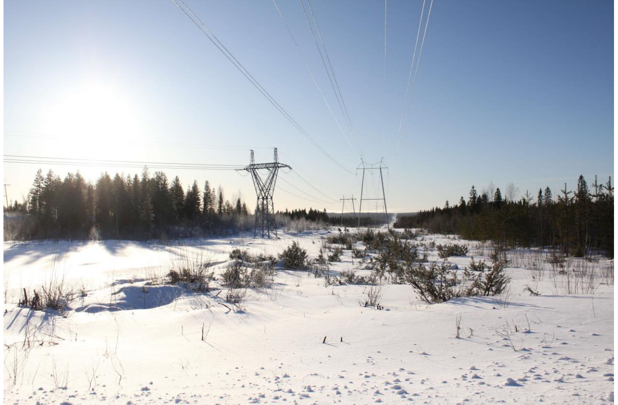
Voimalinjakäytävä Rynnäsentieltä lounaan suuntaan avautuvassa näkyössä.
