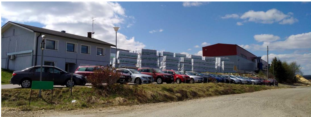
Sahan alueen rakennuskantaa: toimistorakennus ja varastohalleja.
