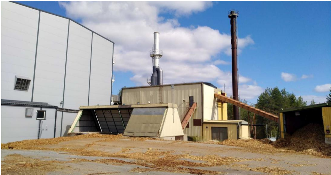
Lämpölaitos sijaitsee saha-alueen itälaidalla.
