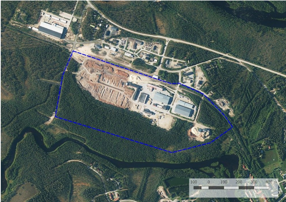
Kaava-alue ortokuvalla, josta voi havaita sen olevan pääosin metsää saha- ja lämpövoimalan alueiden ulkopuolella. Tausta-aineisto Mml (10/2019).
