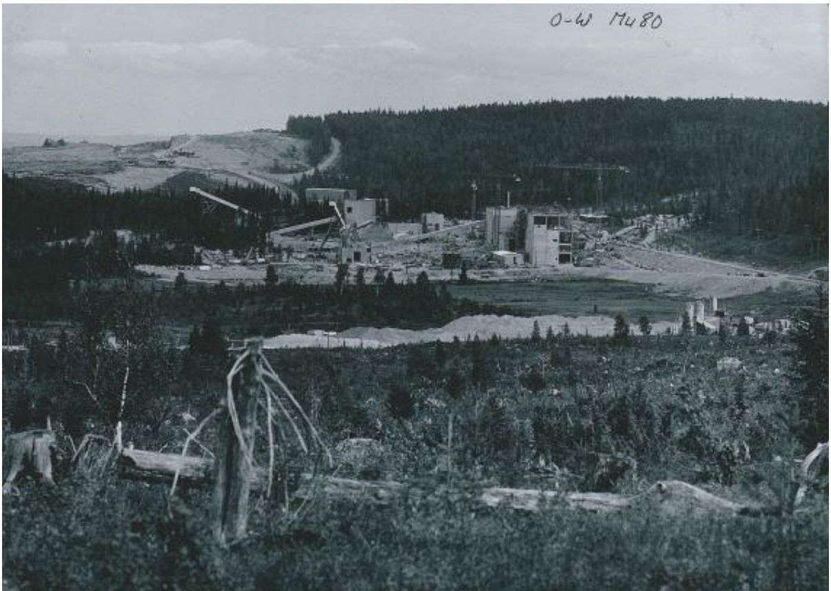
Kuva 12. Näkymä tehdasalueelle läheiseltä rinteeltä aiemman kaivostoiminnan aikana. Rakennukset on purettu. Taustalla louhosalue, joka on nykyisin huomattavasti syvämpi, aukko maisemassa (kuva © Mustavaaran kaivos).
