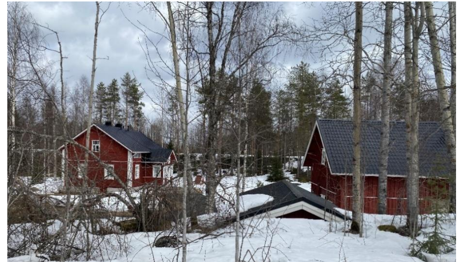
Vahtola-Pukkinen, vanha kunnantalo (kuva Elina Marjakangas, 4/2022).
