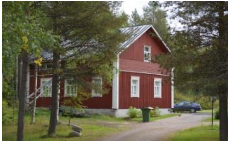
Vahtola-Pukkinen, vanha kunnantalo (Turpeinen, 2014. Lähde: MRKY 2015-inventointi).
