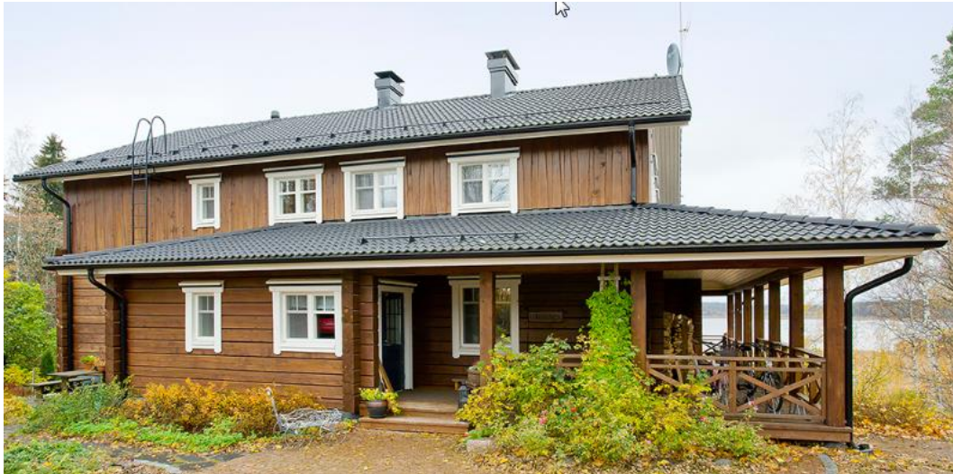
Matalahko, kaksikerroksinen asuinrakennus Aihkitalon mallistosta.
