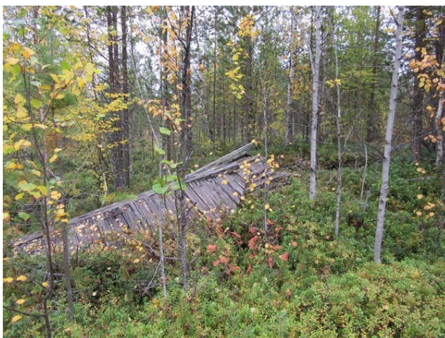
Maakellari kuvattu koilliseen.
